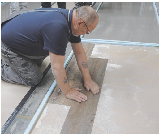
Een deelnemer test of de pvc-banen goed blijven zitten.
