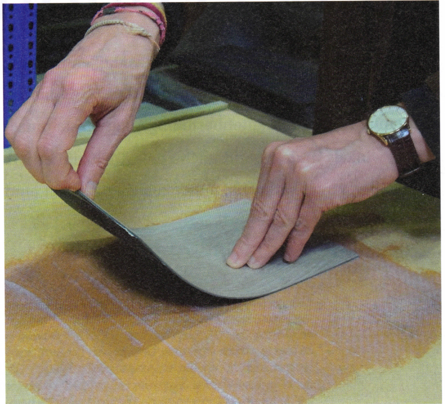
Plinten kunnen tot vier uur na aanbrengen nog verplaatst worden.
