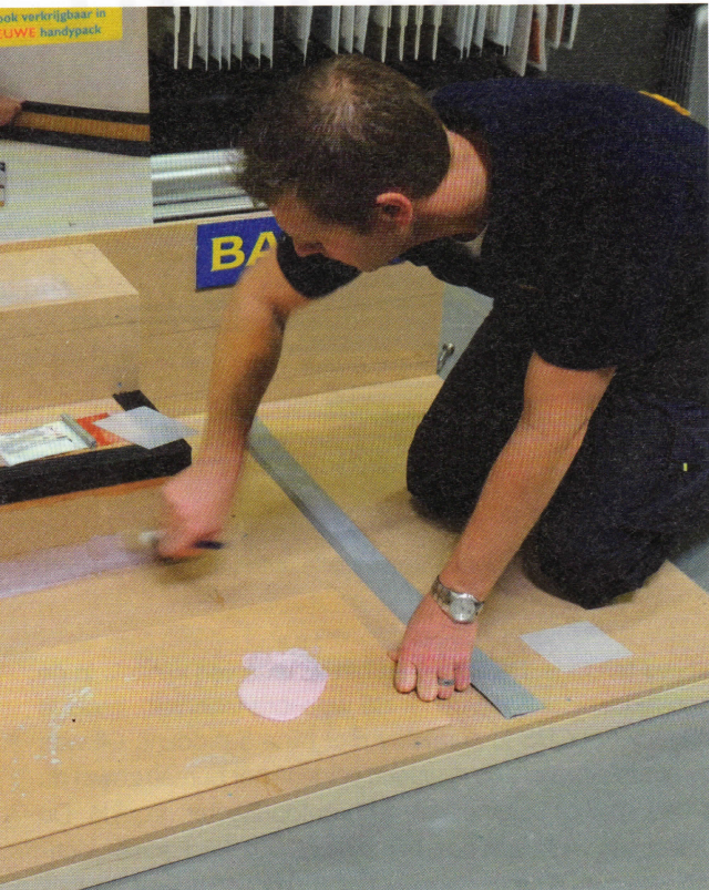
Marc Kemperman brengt Styccobond F49 aan.
